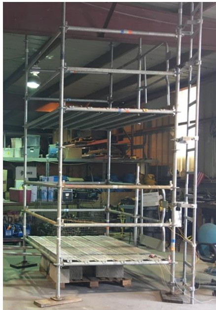
a. Actual Scaffold Model
